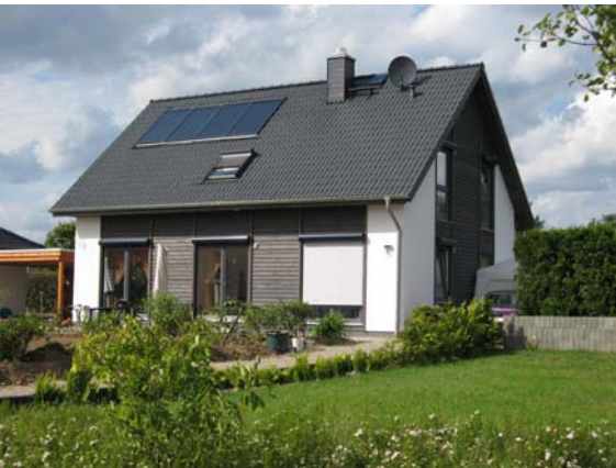
Ansicht nach Fertigstellung
